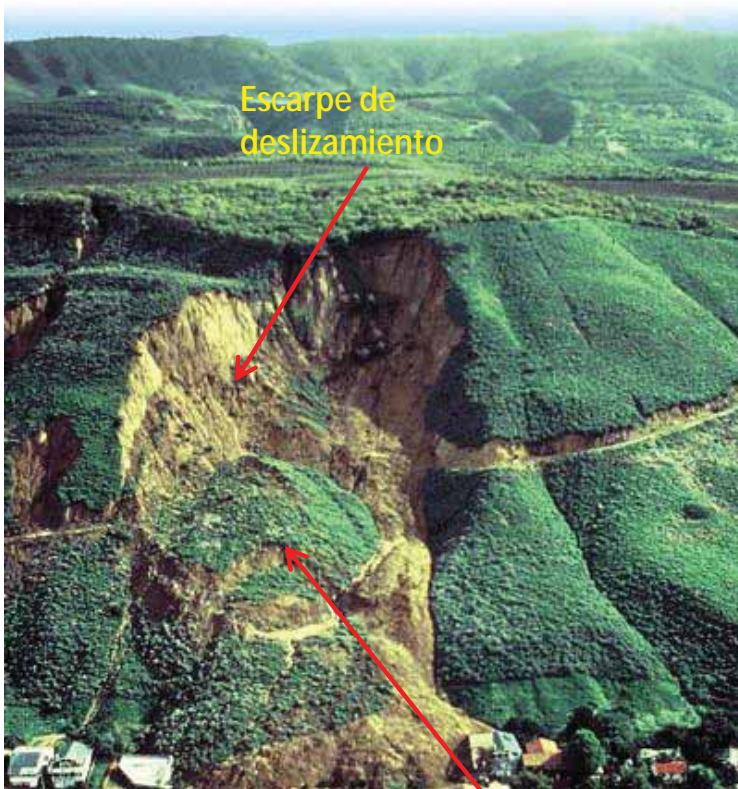
Depósito de deslizamiento
