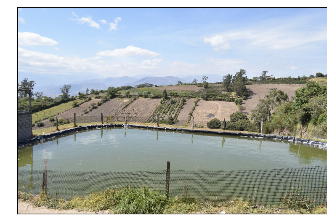
MICRORESERVORIO: Infraestructura donde se almacena agua para riego presurizado.
