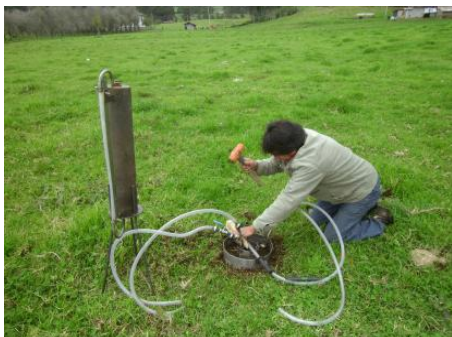
Imagen 4.1. Instalación de los cilindros
