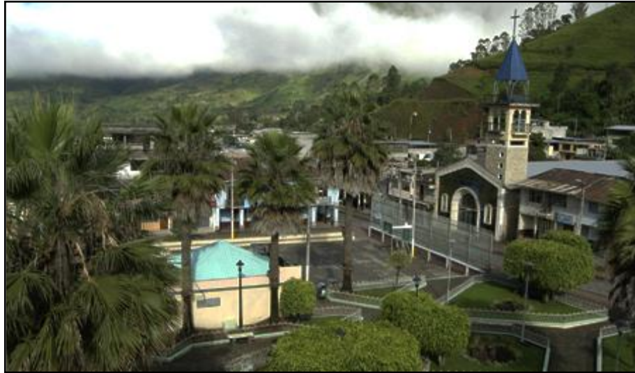
Foto 7.1.3. 1 Zona edificada, Pallatanga
