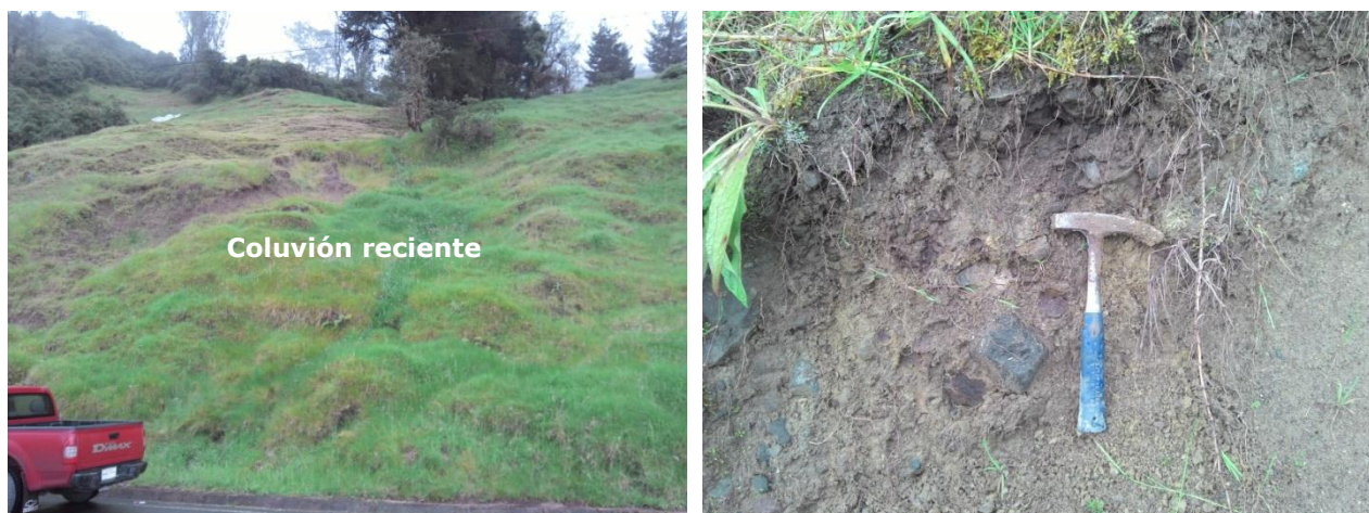
Fotos 29 y 30. Coluvión reciente. Vista general y detalle de los depósitos superficiales. Sector Simbabe. 22/05/2014.
