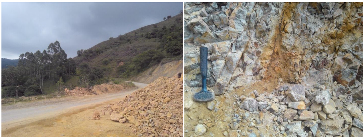
Fotos 5 y 6. Vertiente rectilínea con abruptos. Detalle del macizo rocoso de cuarzodioritas. Sector Loma Quivisara. 29/11/2014.
