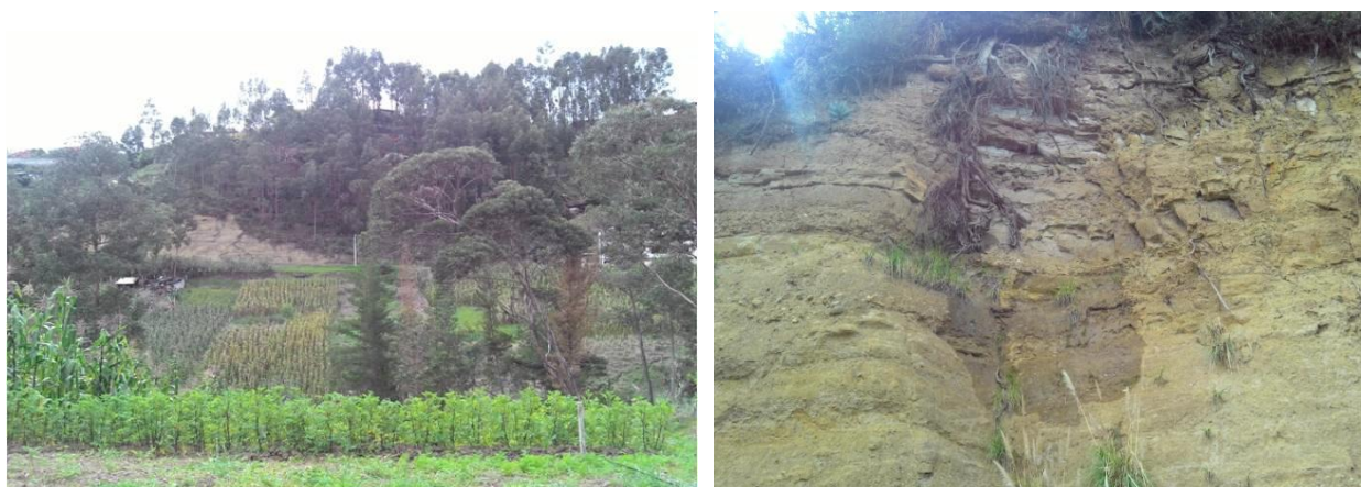
Fotos 7 y 8. Abrupto de cono de deyección. Zona San Francisco, Sector Azogues. 07/04/2014.
