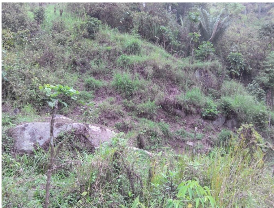
Foto 15. Depósitos de deslizamiento, masa deslizada. Sector El Carmen de Pijilí. 22/10/2014.
