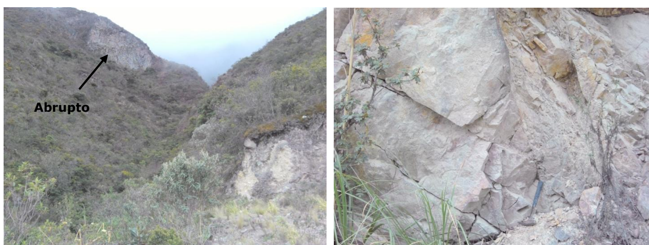
Fotos 17 y 18. Vertiente rectilínea con abruptos. Vista general (izquierda) y detalle del macizo rocoso con andesitas de la Formación Tarqui (derecha). Sector loma Zhingayshine. 24/10/2014.
