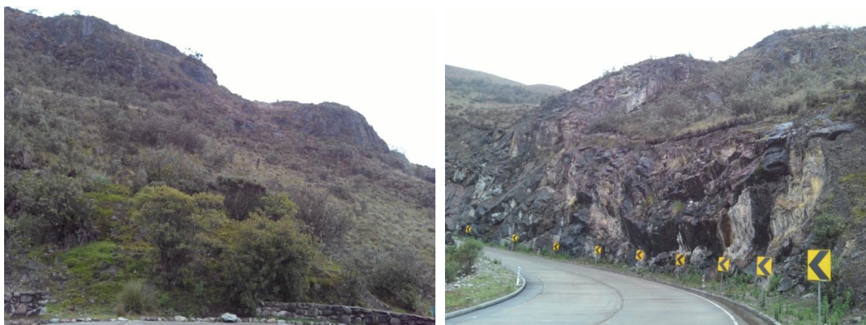
Fotos 23 y 24. Vertiente rocosa. Vista general (izquierda) y detalle del macizo rocoso con riolitas de la Formación Tarqui (derecha). Sector Piedra Puntonal. 08/04/2014.
