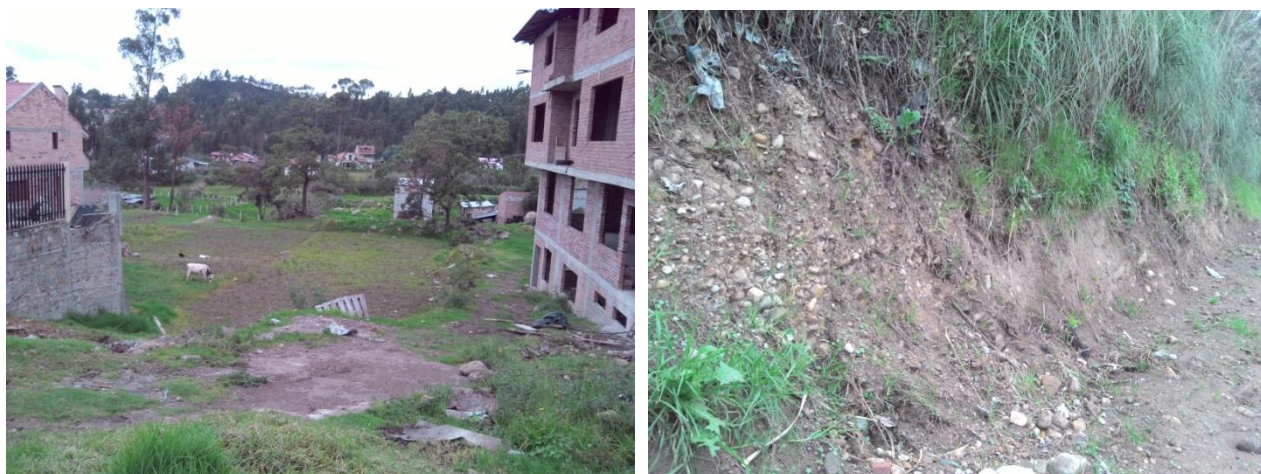
Fotos 5 y 6. Vista general terraza alta (izquierda). Detalle del depósito superficial (derecha). Sector San Joaquín. 07/04/2014.
