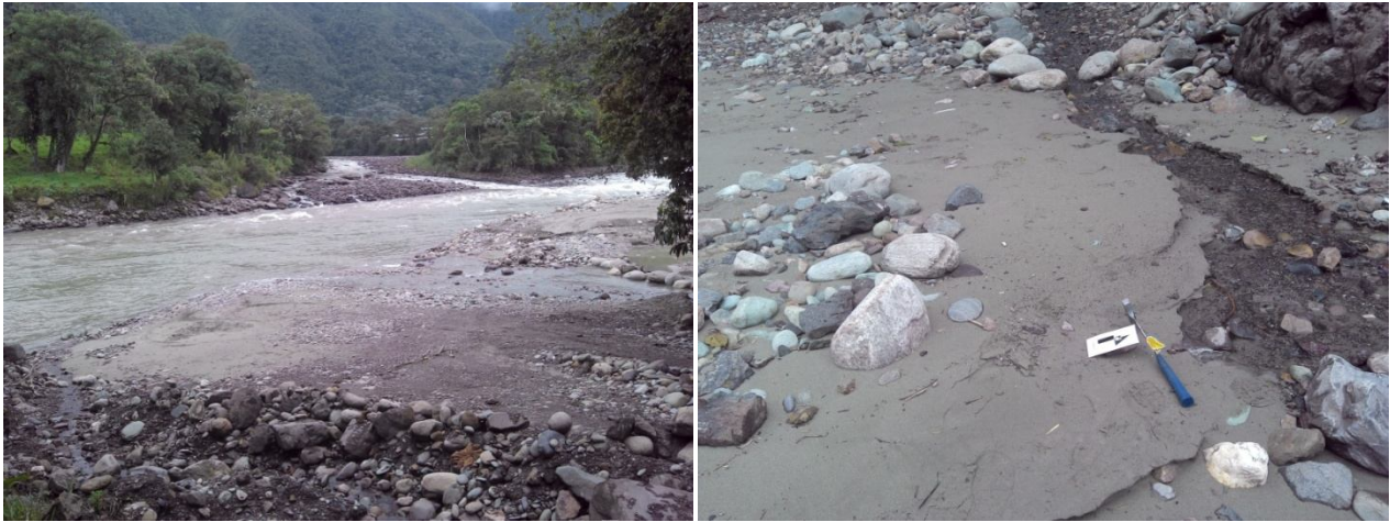
Foto 2 y 3. Terraza baja y cauce actual (sobreexcavación de cauce en llanura de inundación). Vista general (izquierda) y detalle del depósito aluvial (derecha). Sector Santa Rosa de Quijos (intersección entre Río Quijos y Río Oyacachi). 08/12/2014.
