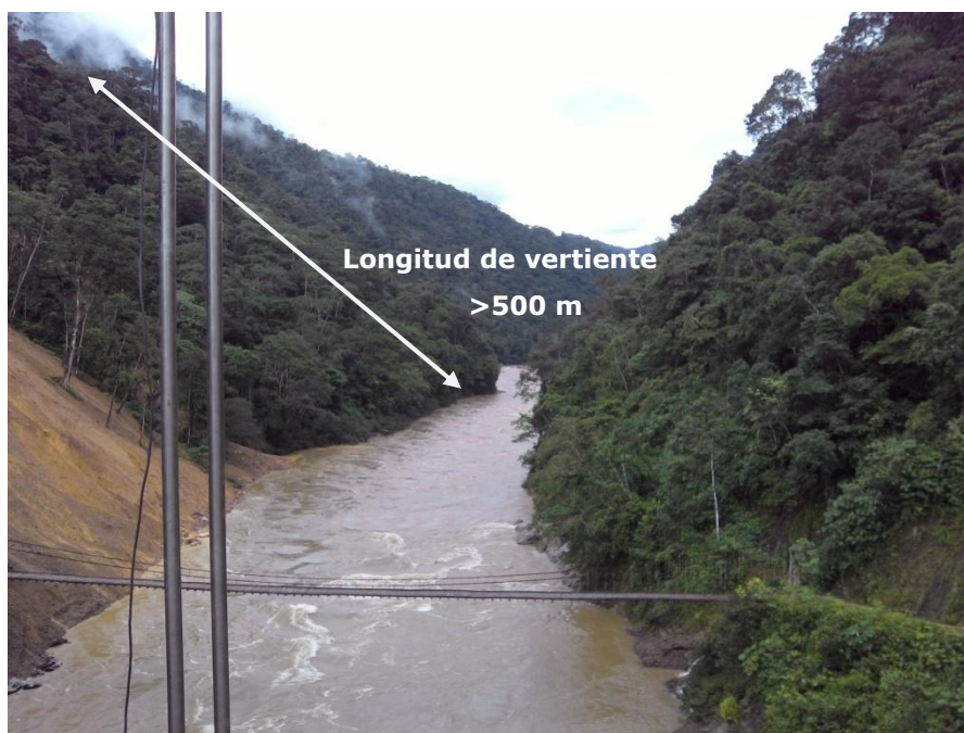
Foto 4. Vista general del encañonamiento en el río Zamora a su paso por La Victoria. 09/08/2014.
