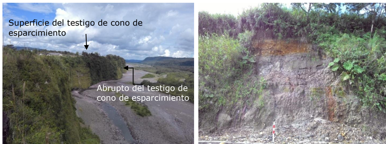
Fotos 8 y 9. Testigo de cono de esparcimiento. Vista general y detalle del macizo rocoso, Fm. Mera. Sector Mera. 08/06/2014.
