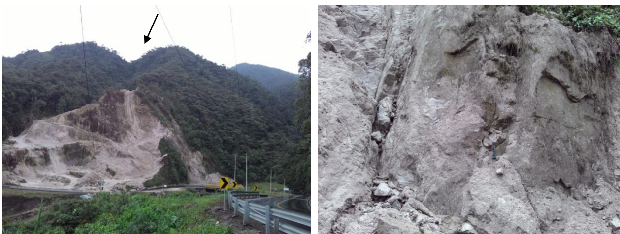
Fotos 13 y 14. Vertiente abrupta con fuerte disección. Vista general y detalle del macizo rocoso, granito del Granito de Abitagua-Guacamayos. Sector Los Ángeles. 09/06/2014.
