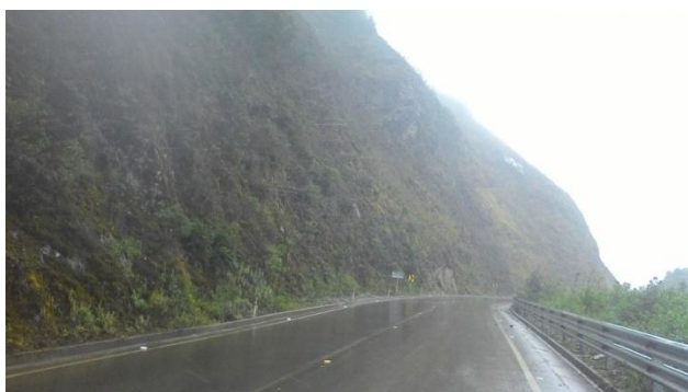
Fotos 18 y 19. Vertiente abrupta en Serie Metaturbita. Vista general (izquierda) y detalle del macizo rocoso, metagrauvascas (derecha). Sector Tambo de Ashilan. 05/08/2014.
