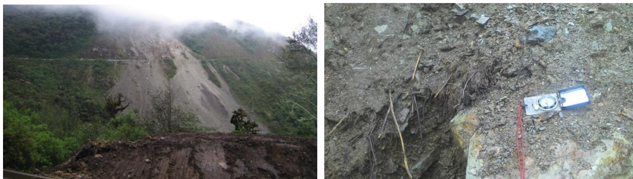
Fotos 24 y 25. Depósitos de deslizamiento, masa deslizada. Vista general (izquierda) y detalle del depósito superficial (derecha). Sector Tambo de Ashilán. 05/08/2014.
