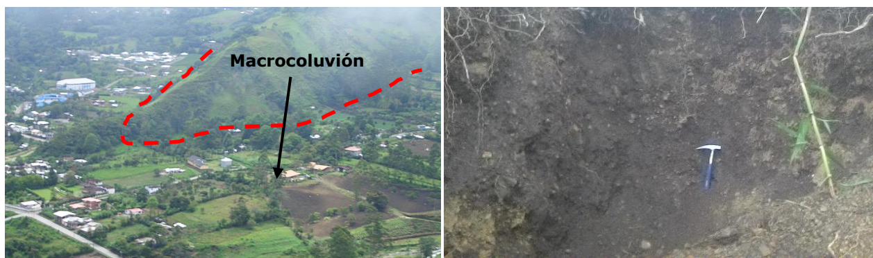
Fotos 17 y 18. Macrocoluvión y detalle de depósito superficial. Sector Pallatanga. 24/05/2014.
