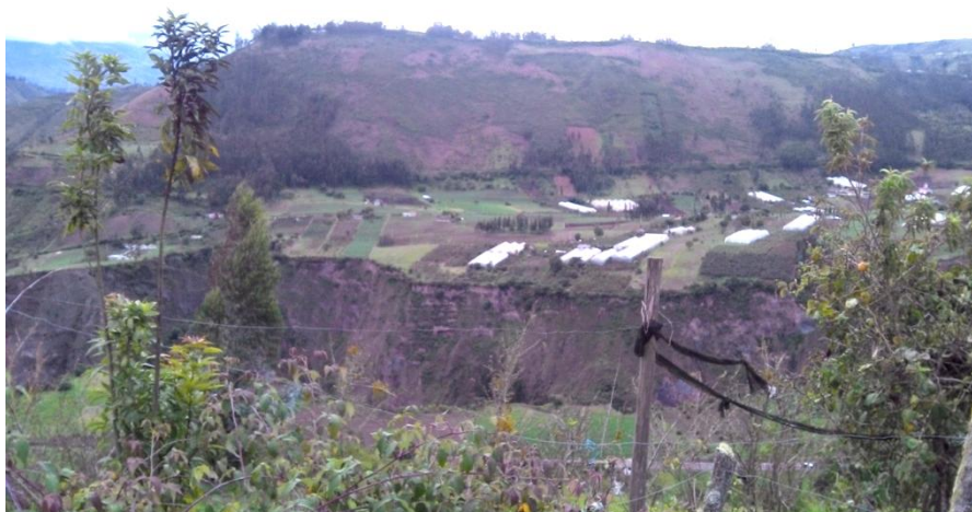
Foto 3. Terraza colgada sobre el cauce del río Pocahuaycu. 05/06/2014.
