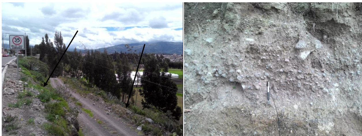
Fotos 8 y 9. Vertiente o abrupto de terraza. Vista general (izquierda) y detalle del depósito superficial (derecha). Depósitos aluviales (terrazas). Sector margen derecha de río Chibunga, suroeste de la ciudad de Riobamba. 04/06/2014.
