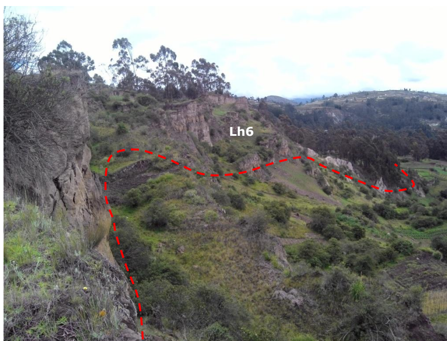
Foto 14. Escarpe de deslizamiento. Sector localidad de San Francisco de Asís. 04/06/2014.
