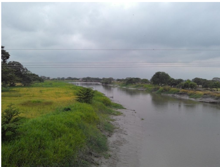
Foto 1. Terraza baja y cauce actual (sobreexcavación de cauce en llanura de inundación). Sector La Delicia, río Vinces. 02/11/2014.
