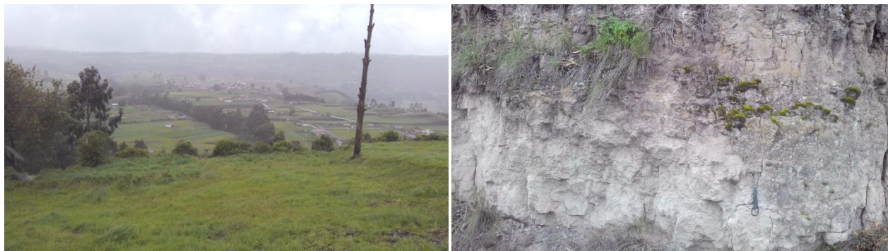
Fotos 21 y 22. Superficie horizontal y detalle del macizo rocoso (Formación Cangahua). Sector quebrada Santo Domingo. 06/06/2014.
