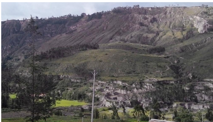
Foto 15. Depósitos de deslizamiento, masa deslizada. Sector Loma Chitahuasi. 05/06/2014.
