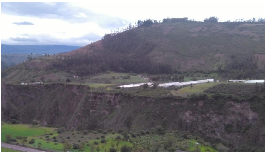
Foto 7. Terraza colgada sobre el cauce del río Pocahuaycu. Sector Loma Chuzalongu. 05/06/2014.
