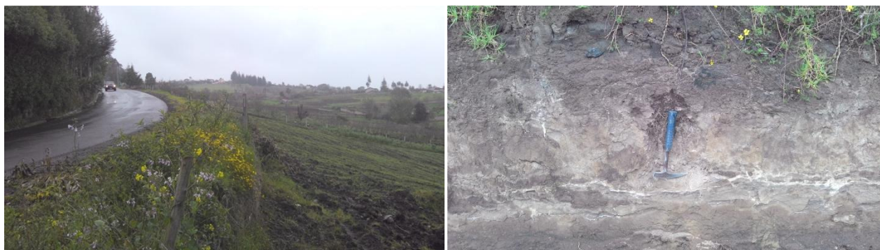
Fotos 23 y 24. Abrupto de superficie horizontal y detalle del macizo rocoso (Formación Cangahua). Sector La Unión. 05/06/2014.
