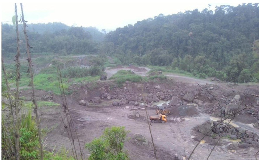
Foto 38. Superficie intervenida. Sector norte, margen izquierda del río Toachi. 21/10/2014.
