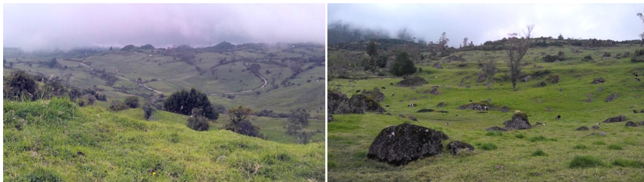
Fotos 2 y 3. Macrocoluvión. Vista panorámica y fotografía de detalle, sector Guizhazhuma. 22/05/2014.
