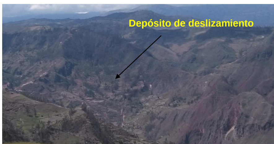
Foto 22. Depósitos de deslizamiento, masa deslizada. Sector Lugmahuacu. 10/12/2014.
