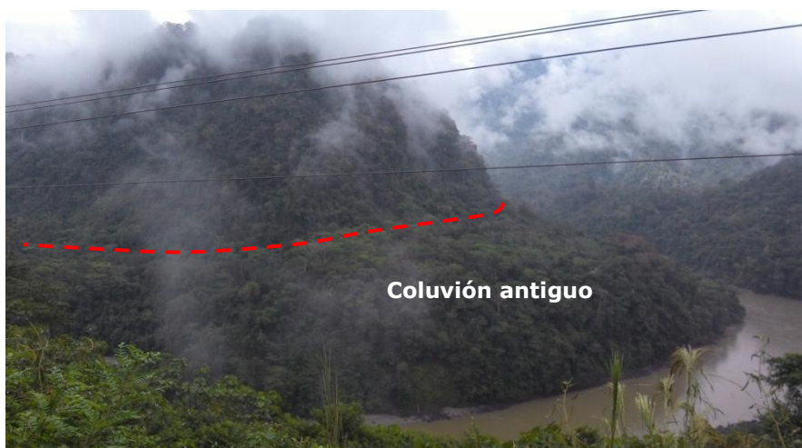
Foto 13. Coluvión antiguo. Sector Palomino, en el margen derecho del río Santiago. 15/09/2014.
