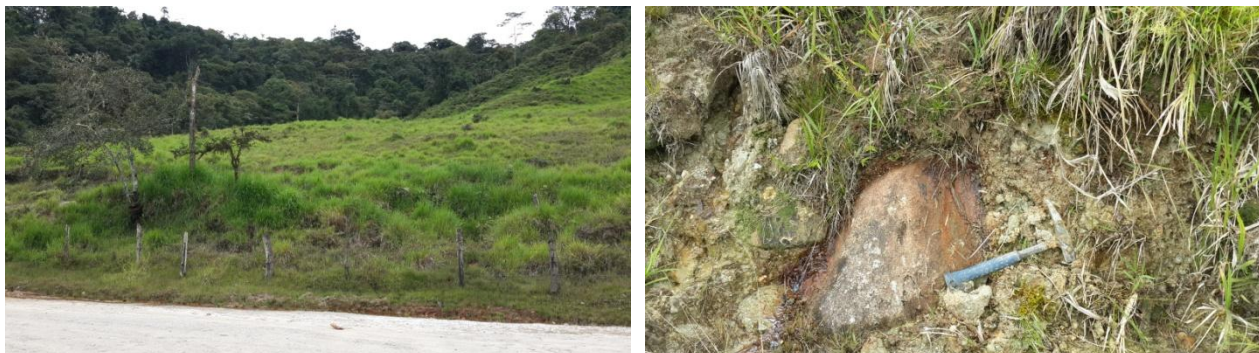
Fotos 21 y 22. Coluvión antiguo. Vista general y detalle del depósito superficial, bloques heterométricos de composición polimíctica en un matriz areno-arcillosa de color crema. Sector Romerillos Alto. 08/02/2015.
