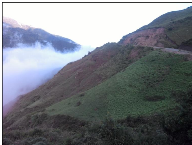
Foto 7.2. Zonas con amenaza Muy Alta a erosión hídrica en el cantón Suscal
